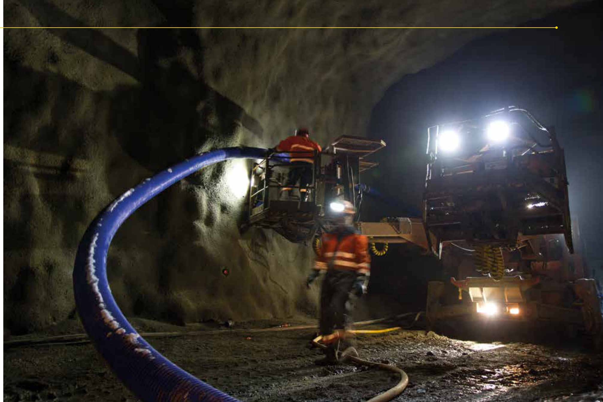
Tunnelien suunnittelu on Suomessa käynyt monimutkaisemmaksi viime vuosikymmeninä. Suuri osa teknisistä järjestelmistä on EU-direktiivien myötä pakollisia.
